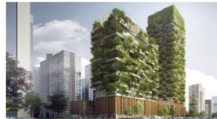
Bosco Verticale, Milan Fan Coils
