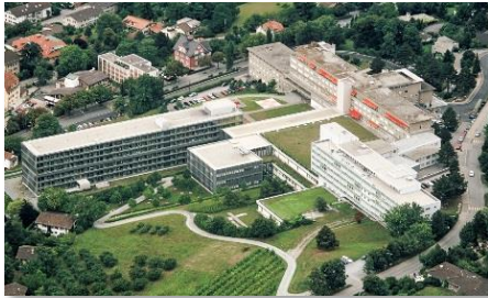
«The Circle» – die grösste Baustelle der Schweiz
